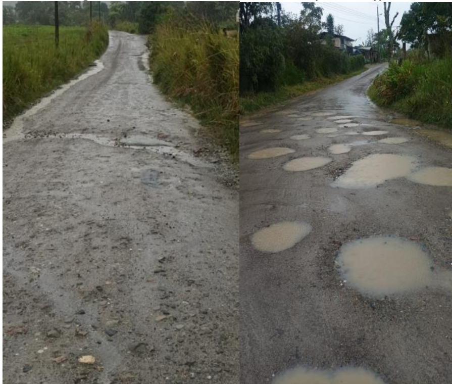
Fotografía 6. Estado vial, tramos de la vía Campo Libre-Bypass
