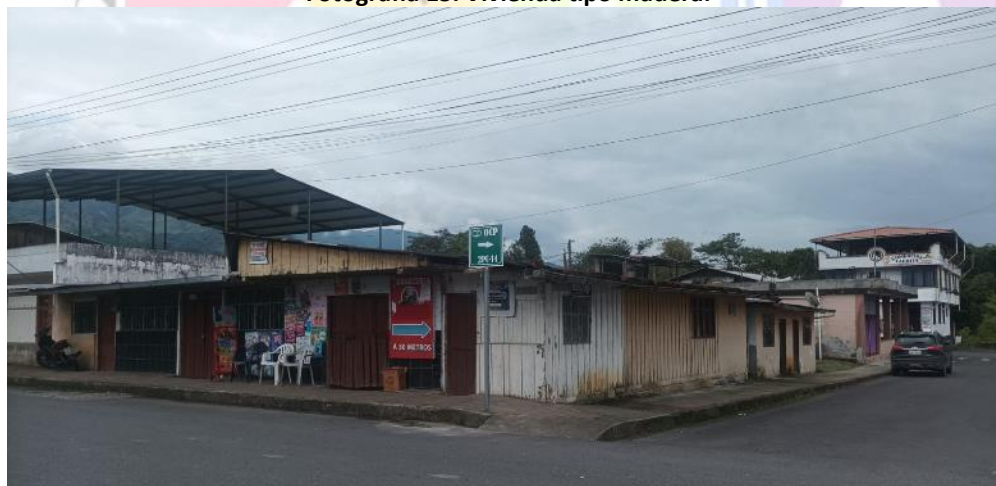
Fotografía 15. Vivienda tipo madera.
