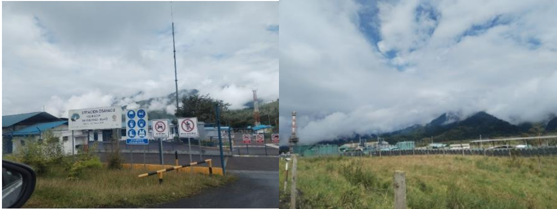
Fotografía 5. Imagen de instalaciones de estaciones Osayacu y Sardinas – Plus Petrol
