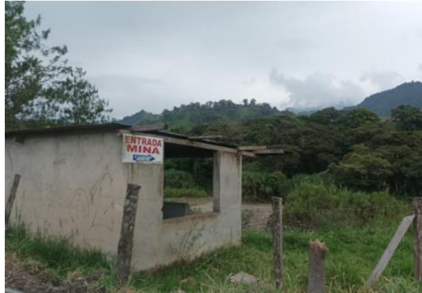
Fotografía 1. Entrada a la mina Jhannyne
