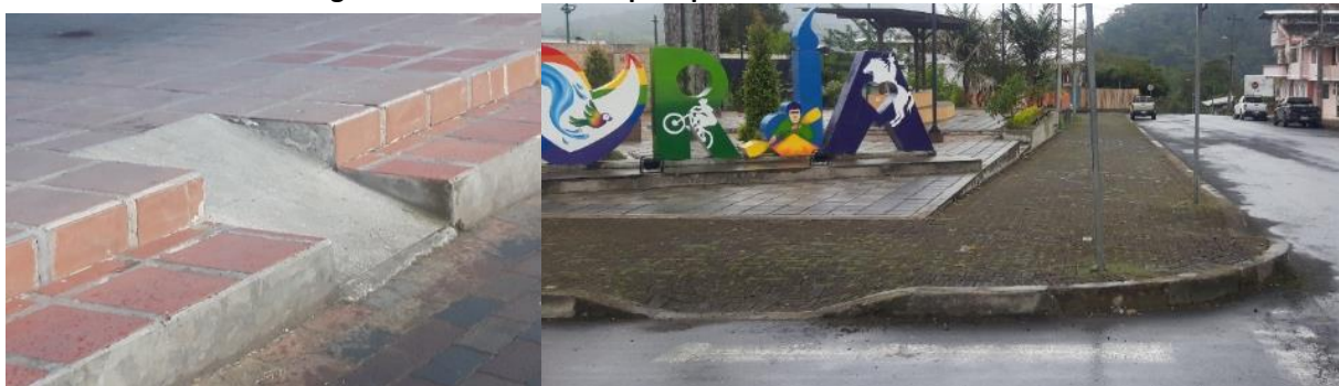
Fotografía 8. Infraestructura para personas de movilidad limitada.
